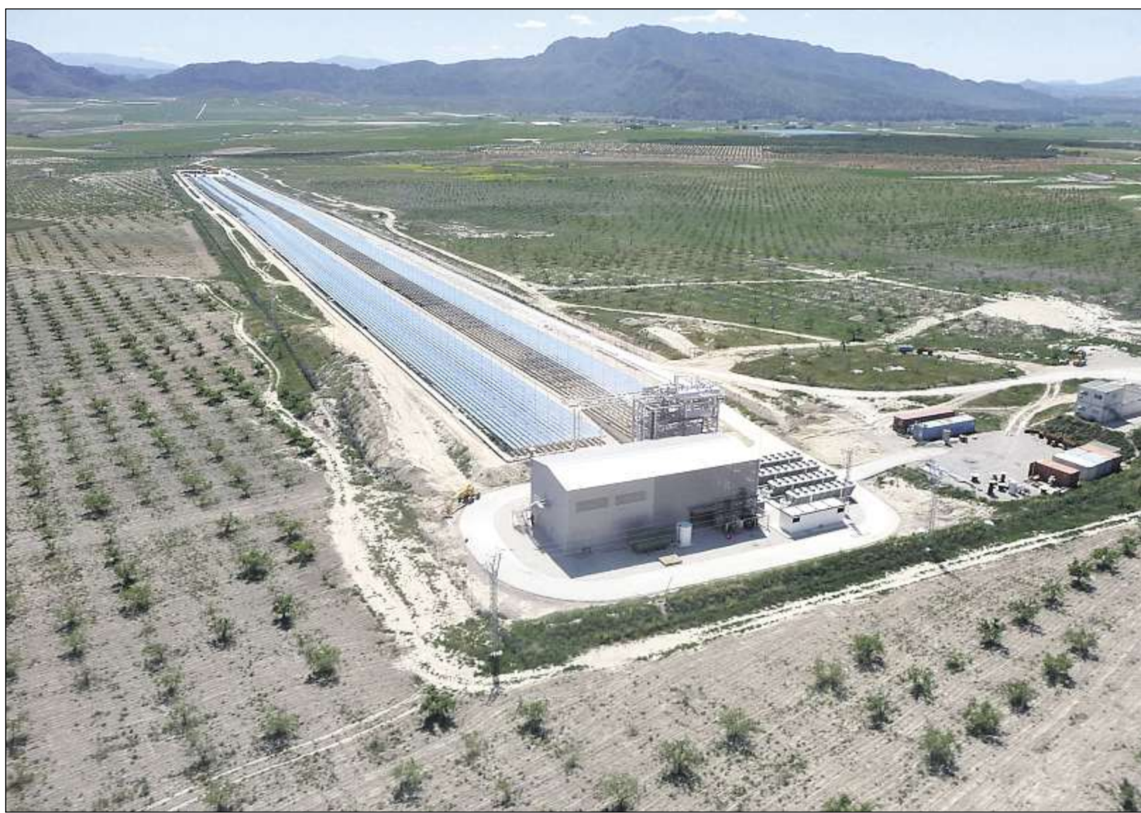
UNTER SPANISCHER SONNE: Das Solarkraftwerk der Karlsruher Firma Novatec Biosol in der Region Murcia liefert Strom für 2 000 Haushalte. Fotos: pr
